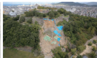
図 19 事故当時の石垣の崩落状況 (出典: 丸亀城 HP)
