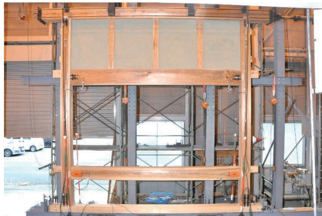
写真4 垂れ壁試験体設置状況
