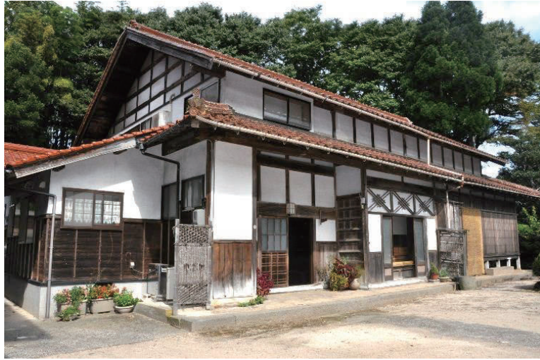
写真1 対象住宅外観
