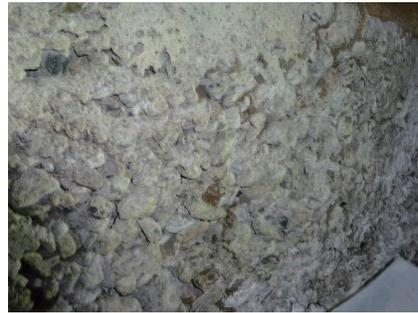
図12 基礎コンクリートの表面
