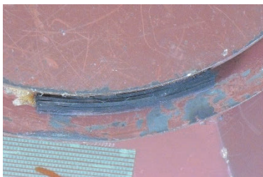
写真 6 防振ゴム取付状況
