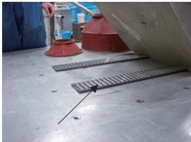
写真 9 ①基壇下のローラー支承
