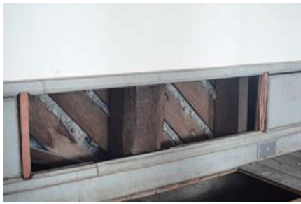
図11 2階モルタル壁
