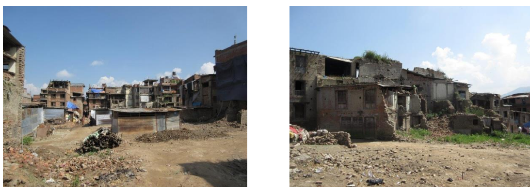
図1 甚大な建物被害が集中的に発生したダッタトラヤ広場の南側のエリア（2015年10月の様子）
