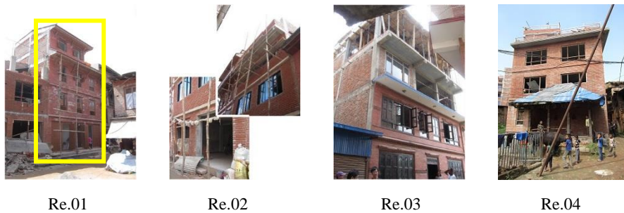
図8 Group3 : 再建途中の建物 (RC枠組補強煉瓦造建物) の外観
