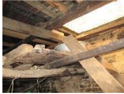
図13 屋根部分の構面の破壊の事例 (His.01)
