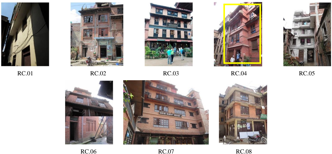
図6 Group2 : RC枠組補強煉瓦造建物の外観
