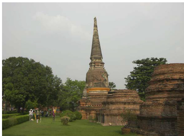
図1 地盤沈下等の影響を受けて傾斜しているタイ国アユタヤ遺跡ストゥーパ 1)
