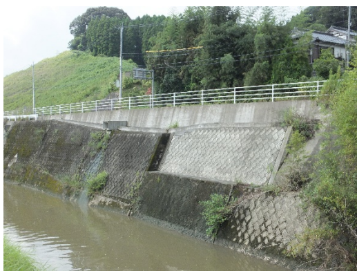
図3 熊本地震（2016年）の震源隣接区域における地震直後の網状鉄筋挿入工による構造物の追跡状況調査例
