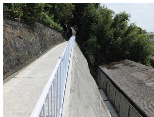
図3 熊本地震（2016年）の震源隣接区域における地震直後の網状鉄筋挿入工による構造物の追跡状況調査例
