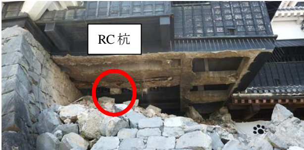
写真-3 天守の基礎部分のRC梁
