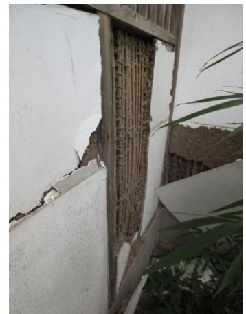
写真2 土壁の損傷
