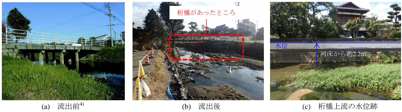
写真1 久保島の石造桁橋の流出前後および豪雨時の水位の痕跡
