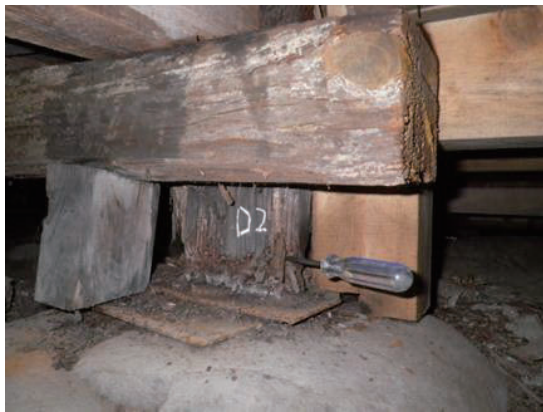
図4 柱下部の劣化状況（左：X3-Y3、右：X6-Y3）
