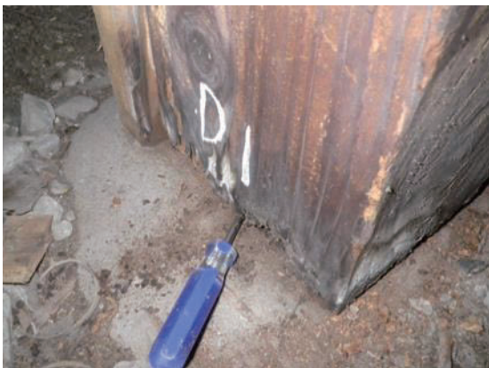
図5 柱下部の劣化状況（左：X14-Y3、右：X14-Y2）
