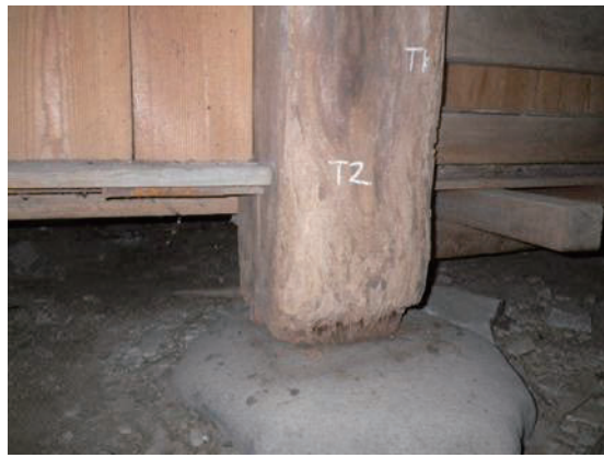
図3 柱下部の劣化状況（左：X12-Y1、右：X9-Y3）
