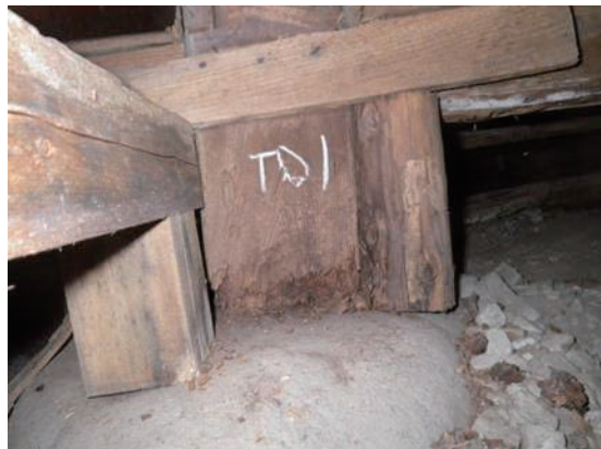
図4 柱下部の劣化状況（左：X3-Y3、右：X6-Y3）
