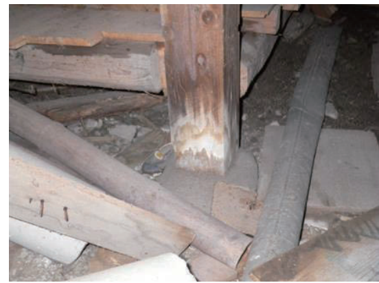
図5 柱下部の劣化状況（左：X14-Y3、右：X14-Y2）
