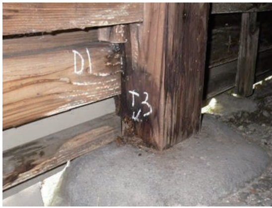
図3 柱下部の劣化状況（左：X12-Y1、右：X9-Y3）
