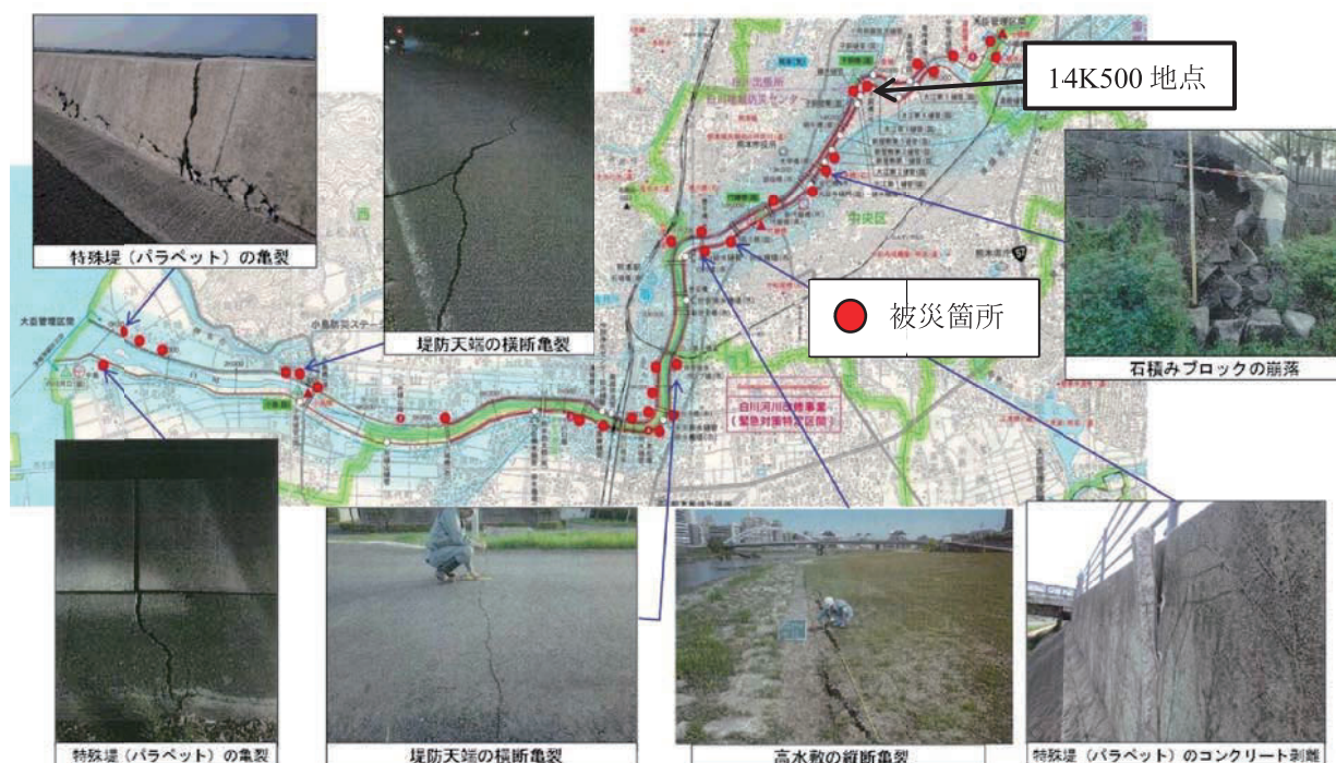
図3 白川流域の国土交通省管理区間の堤防などの被災状況
