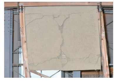
垂れ壁のせん断破壊
