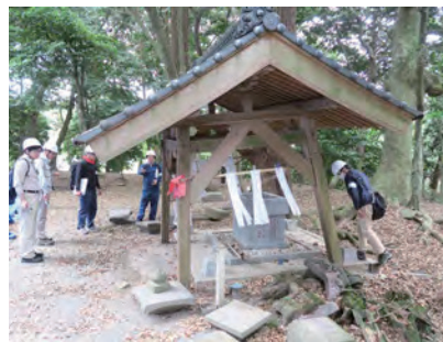
写真2 手水舎と移動した柱脚
