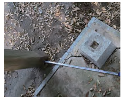
写真2 手水舎と移動した柱脚
