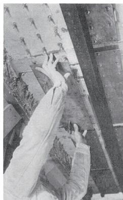
図8 壁裏鋼板取付
