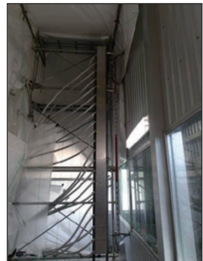
図4 集水パネル壁面
