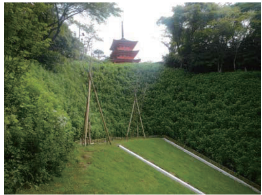
写真 3 緑の斜面に再生された斜面 3 の状況
