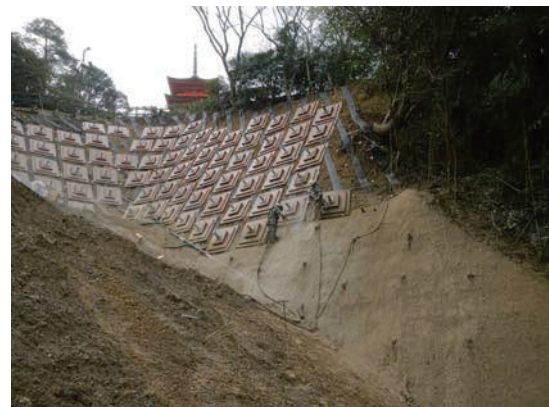
写真1 グラウンドアンカー工打設後の斜面3 1400×1400mmのサイズの受圧板に覆われる。 (斜面末端では連続繊維補強土工の施工が始まっている)
