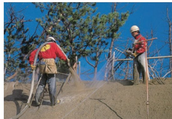
写真2 連続繊維補強土工施工状況
