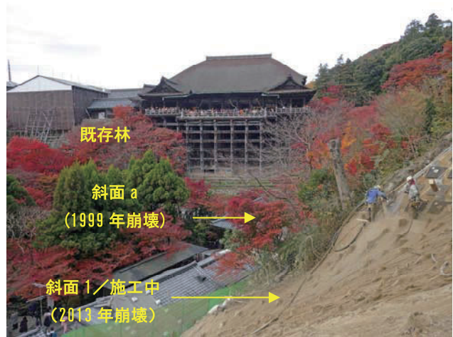
写真6 復旧対策後15年が経過した斜面aの状況 左は舞台上から、右は舞台を背景に撮影した写真。
