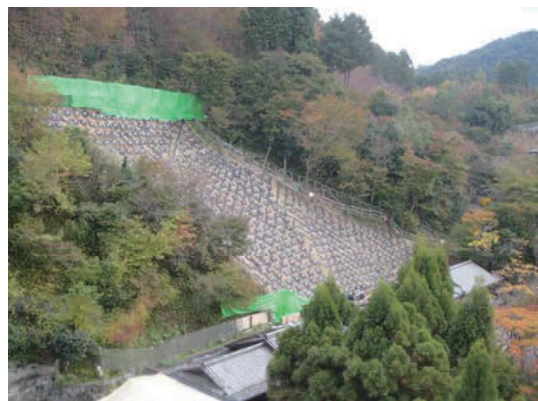
写真 4 鉄筋挿入工実施後の斜面 1 647×647mm のサイズの受圧板が 1m 間隔で並ぶ。
