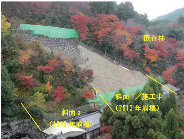
写真6 復旧対策後15年が経過した斜面aの状況 左は舞台上から、右は舞台を背景に撮影した写真。
