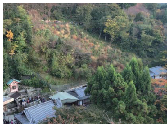
写真 5 復旧対策完了後 1 年が経過した斜面 1
