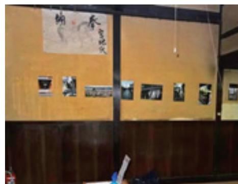
写真2 土壁と板壁を複合した特徴的な壁（宮地家）
