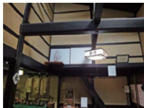
写真1 大きな吹き抜け空間と踵しの貫を有する土壁（宮地家）
