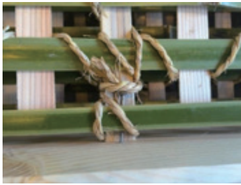
写真7 間渡し竹端部の納まり
