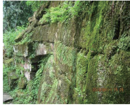
図6 擁壁の崩壊
