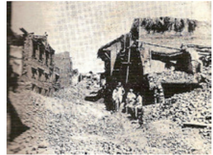
写真1 崩壊した住宅の瓦礫と道路の様子
