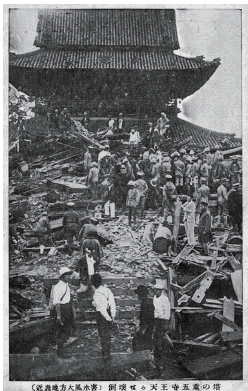
図3 四天王寺五重塔の倒壊状況を撮影した災害写真
