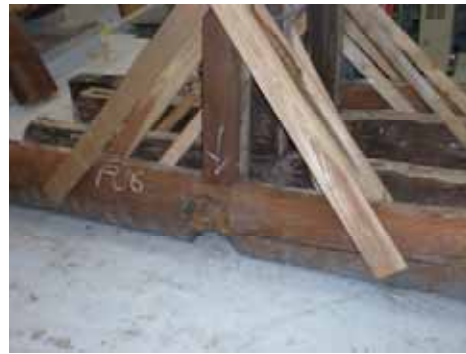
写真 4 福山の民家から搬入した試験体
