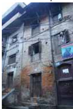
図3 Jhatapol地区の住宅専用建物の例
