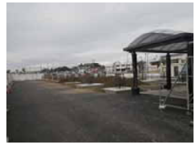
b 建設中の新交流館
