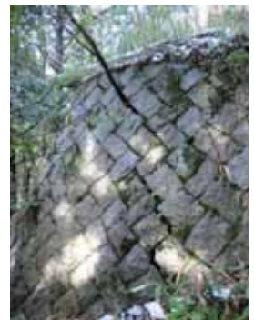
写真2 貯水槽南側擁壁
