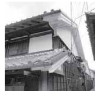
図5 2階平壁の漆喰以外の不燃材
