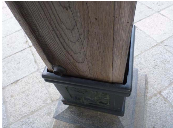
写真2 竹駒稲荷神社向唐門の柱基部
