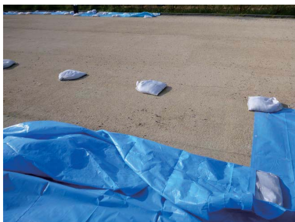
写真16 仙台城跡の石垣の崩れによるひび割れ
