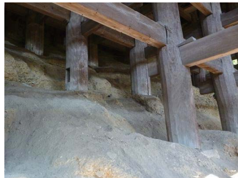
写真1 舞台下斜面の現況
