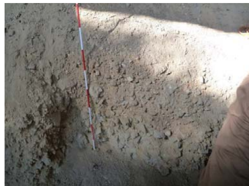
写真2 斜面表層の固結地盤
