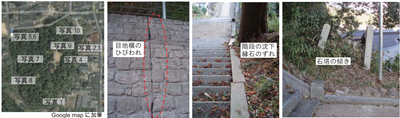
図9 現地踏査写真位置図 写真1 天神山南側擁壁 写真2,3 宝厳寺山門と山頂を結ぶ階段
