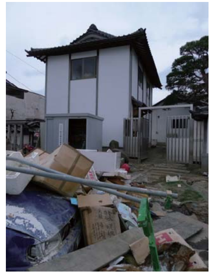
図7 境内入口に設置された中央正和会の防災備品収納庫 (手前)と永巖寺の蔵(奥)
