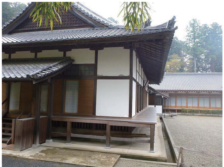
図3 瑞巖寺修行道場の外観
