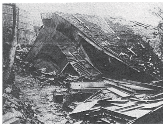
図3 由比ヶ浜の津波被害の状況 1)
