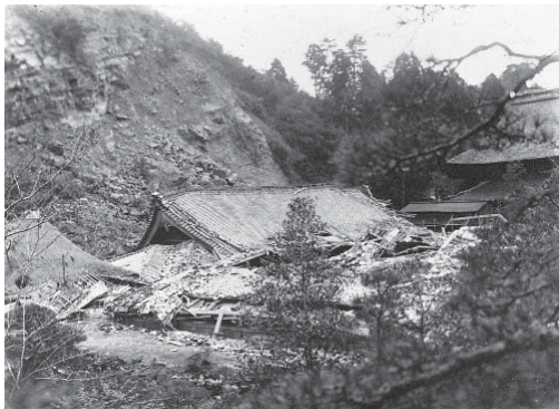
図8 建長寺方丈の被災状況 1)
