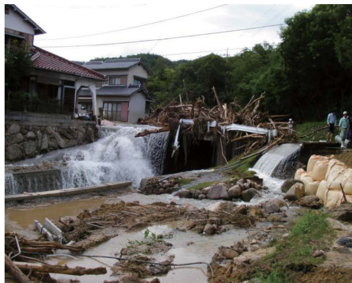
図9 流木による河道閉塞状況
