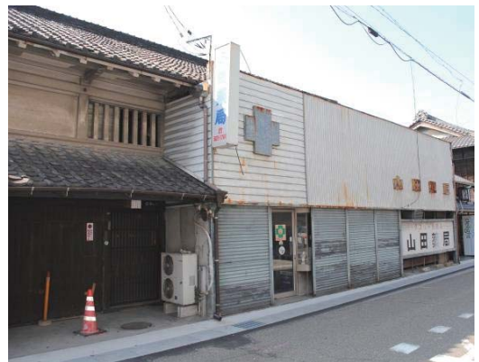
図2 北側外観(一部は鋼製看板で覆われている)
