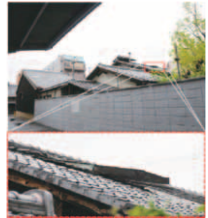
(h) 屋根面における火見櫓の痕跡
