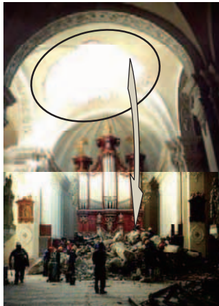
写真11 西鐘楼が堂内に落下
