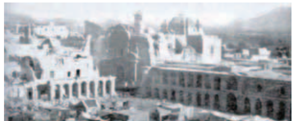
写真9 1868年地震被害のアーケード
