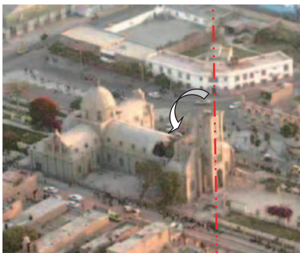
写真3 2007年ピスコ地震被害、鐘楼上部落下
