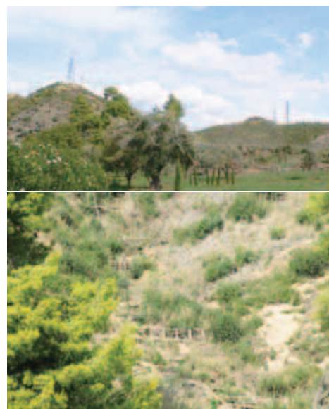
図 22 放水塔（上）と砂防ダム（下）
