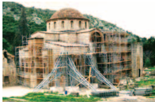
図8 北東の角に設置された支柱
