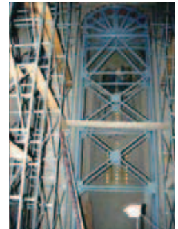
図9 内部の鉛直鋼製支柱
