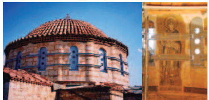
図12 ドラムに対する応急対策（左：外側、右：内部）
