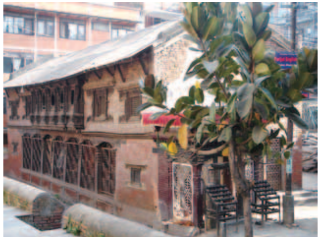
地盤沈下や経年劣化のために建物が歪んでいる。2階窓枠には精緻な彫刻がある。
