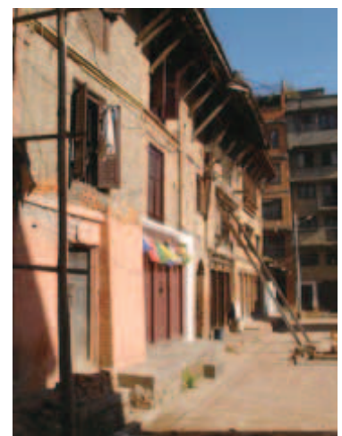
隣接する建物群。孕み出す煉瓦を木の棒で押さえている。
