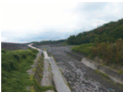
写真3 床止め工の一例
