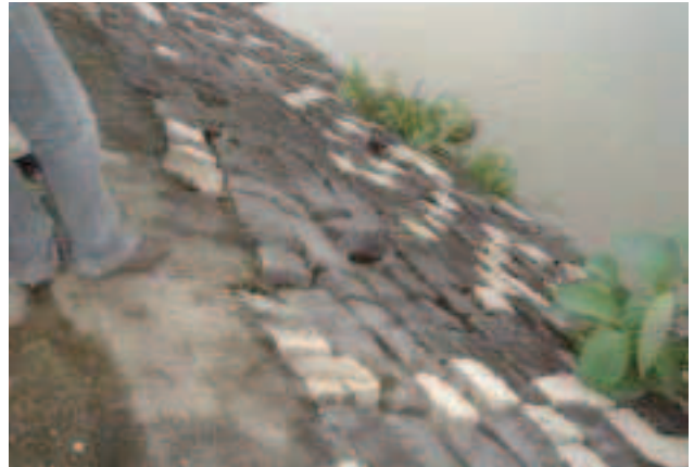
写真4 ティエンムー寺周辺の護岸
