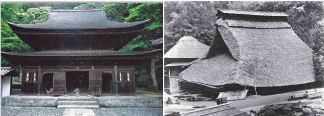
図4. 鎌倉市 国宝「円覚寺舍利殿」の現況 6) （屋根こけら葺き）、1923年関東大震災による倒壊（茅葺き屋根） 7)
