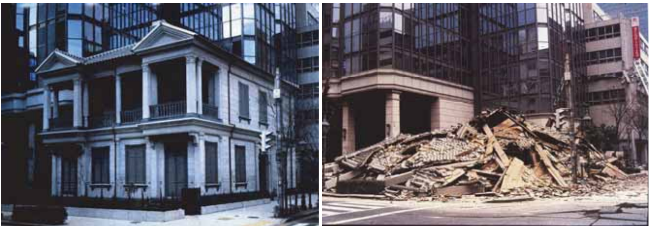
図3. 神戸市 重要文化財「旧神戸居留地十五番館」震災前、1995年阪神淡路大震災での全壊（後方右に中間階屈屈）
