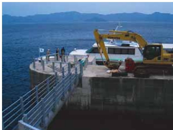
写真5 ドルフィン栈橋と上陸栈橋（提供：やまさ海運株）
