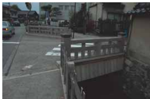
写真 12 桁隠し(長町四の橋)
