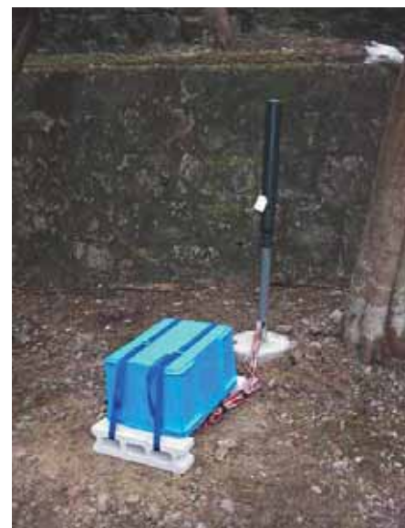
写真3 パイプひずみ計・水位計設置状況
