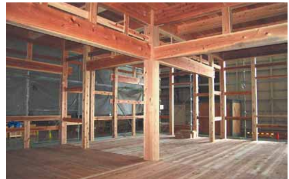
図 7 土壁施工前の A 棟 1 階
