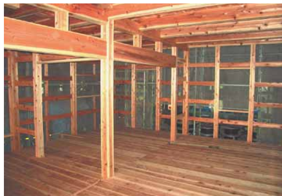
図 11 土壁施工前の B 棟 1 階
