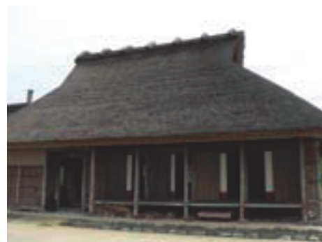
写真3 建物番号NO. 5の全景
