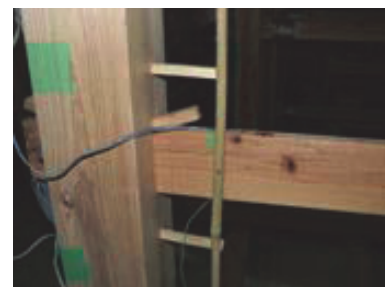
(b) 柱にウグイスを打ち込んだ様子
