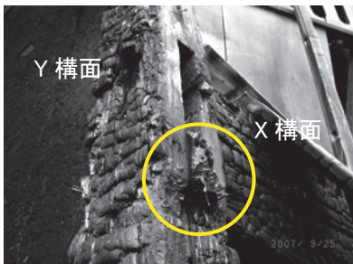
写真4 仕口部分の状況
