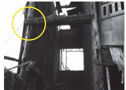
写真6 つなぎ梁の構造
