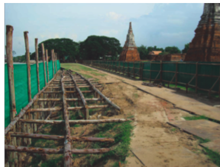
写真 2 遺跡周辺への防水壁の設置
