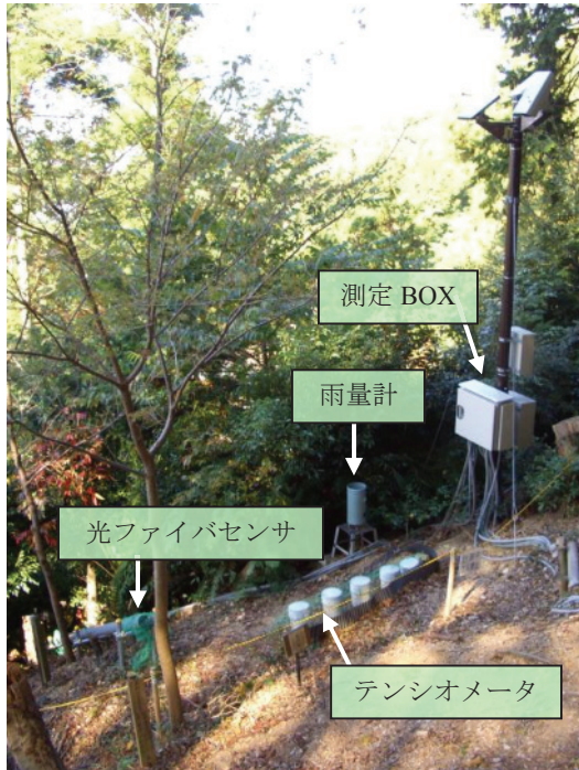
写真 1 計測機器設置状況 (M 地点)
