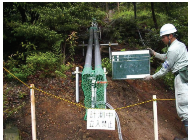
写真 2 光ファイバセンサ設置状況 (②地点)
