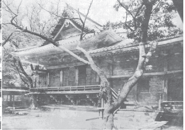
図1-2 被災前の本殿幣殿
