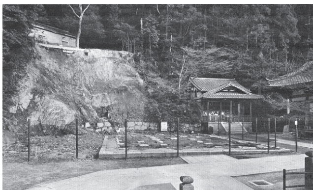
図3-3 復旧工事 土砂取除き部材格納
