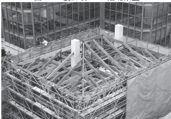
図4-5 復旧工事 煙突RC化し小屋鉄骨補強
