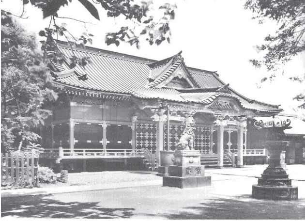
図1-1 復旧竣工 拝殿
