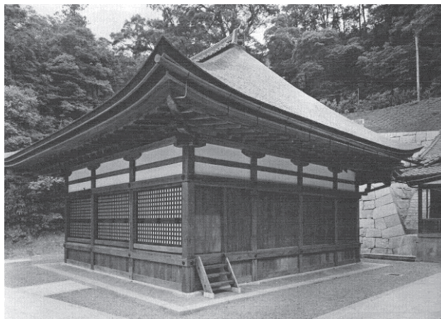
図3-2 復旧竣工 正面
